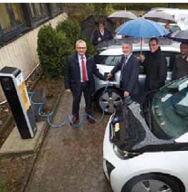
Ende 2016 nahmen Bruno Seibeld, Bürgermeister der Verbandsgemeinde Rhein-Mosel (am Ladestecker rechts) und Josef Rönz, Vorstandsvorsitzender der Energieversorgung Mittelrhein (li.) die jüngste Energie-Zapfsäule in Koblenz-Gondorf in Betrieb.
