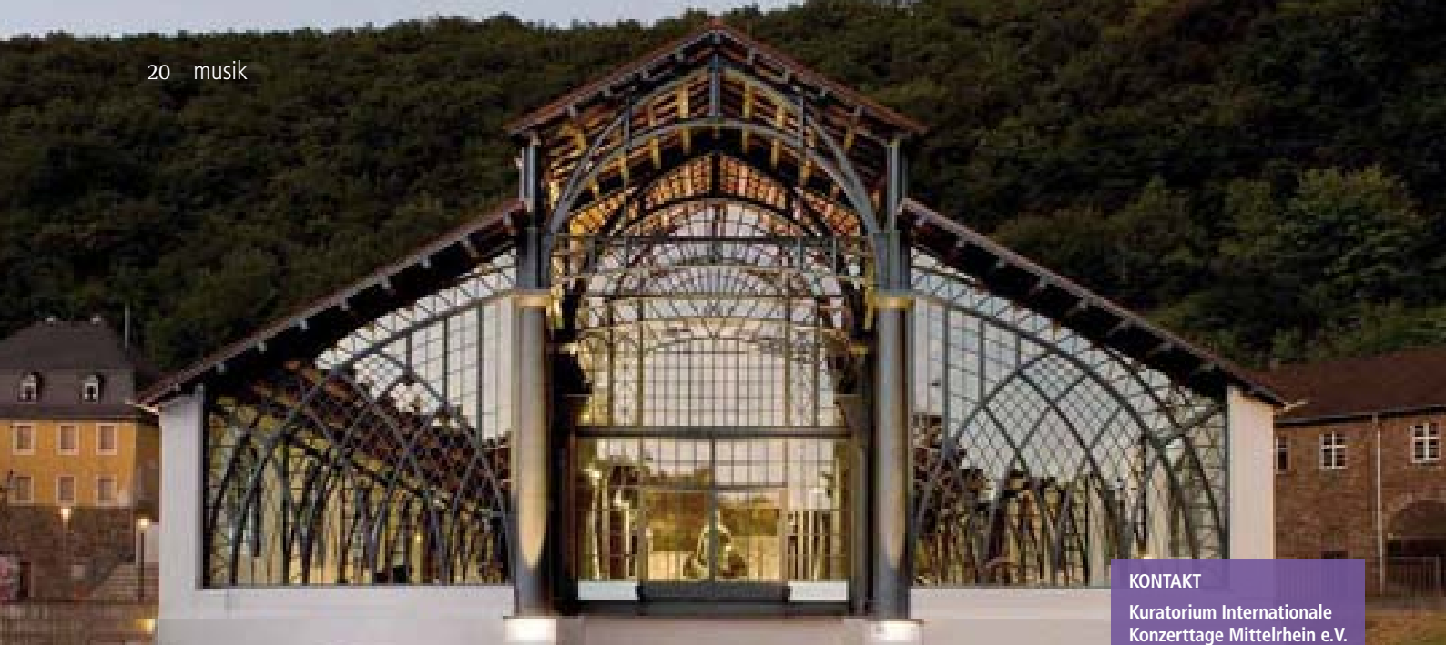
Die Gießhalle der Sayner Hütte ist Schauplatz der „Hollywood Suite“
