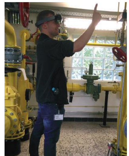
Mitarbeiter Matthias Zimmermann testet die Einsatzmöglichkeiten für AR-Brillen bei der Wartung einer Gasdruckregelmessanlage in Mülheim-Kärlich.
