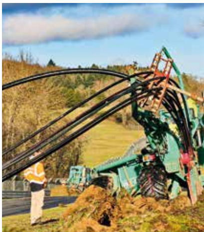
Der Nürburgring wird digital. Im Winter wurde Glasfaser verlegt.
