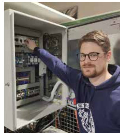
Absolvent Florian Lempert führte seine Forschungsarbeit zur Alterung von Mittelspannungskabeln an dem Prüfgerät durch.
